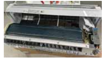
3. Enlevez le couvercle en retirant ces 10 vis.
