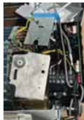
4. Retirez le couvercle de la boîte électrique.
