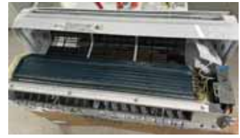
3. Retire la tapa desinstalando estos 10 tornillos.
